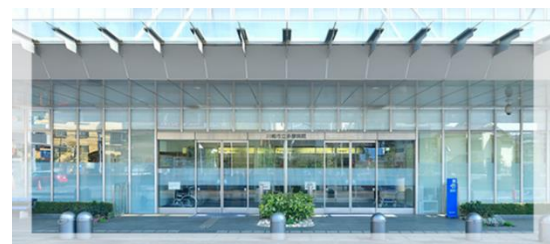
写真：病院正面玄関
